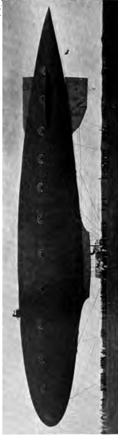
Abb. 12. P. L. 25. L = 113,8 m, D = 16 m, Gasraum = 14 100 cbm, Geschwindigkeit = 22 m/sec. Erster Kriegstyp der deutschen Prallschiffe. In einer großen Gondel Führer-, Funkentelegraphie- und Motorenraum mit zwei Motoren, welche in seitlich an die Gondel angebauten Propellerböden gelagert sind; über der Gondel unter dem Schiff kurzer Laufgang; vorn auf Schiffsrücken M. G.-Stand. Die „Trajektorien“ der gleichmäßigen Verteilung der Last auf den ganzen Schiffkörper deutlich sichtbar.
