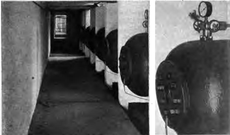
Abb. 40. Unterirdisches Gasochdrucklager Alhorn. Gang vor den durch Zwischenwände gegeneinander abgeschotteten Köpfen der Gastessel; man sieht die Armaturen der Kessel.
