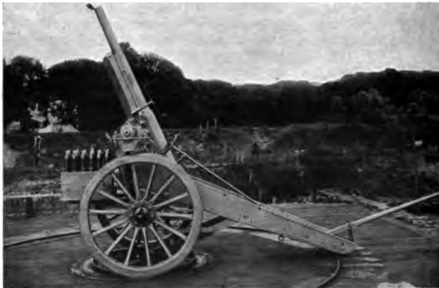
Abb. 203. Deutsches 7,7 cm-Feldgeschütz behelfsmäßig als Flak. Abb. 204. Früheres deutsches Feldgeschütz (9 cm) behelfsmäßig als Flak im sogenannten Schneker-Sattel.
