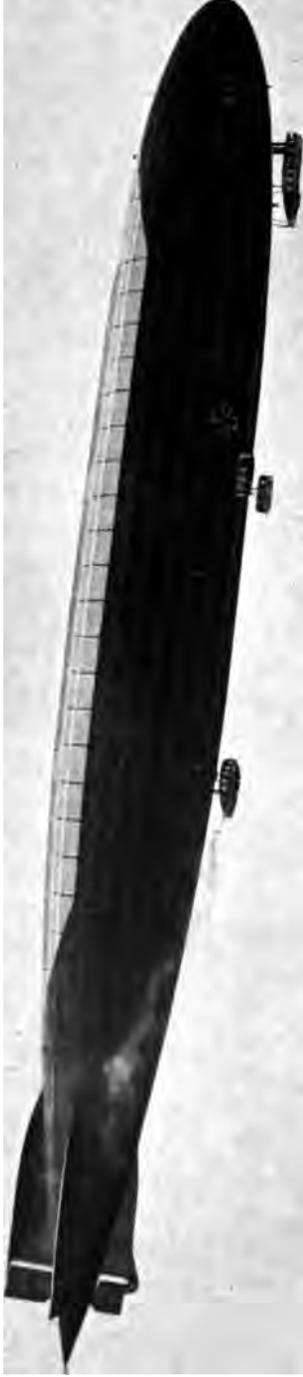
Abb. 9. L. 43. L = 196,5 m, D = 23,93 m, Gasraum = 55 000 cbm, Geschwindigkeit = 27 m/sec. Nordere Gondel wie bei L. 15, hintere mit einem direkt angetriebenen Propeller; außerdem zwei seitlich in der Schiffsmitte aufgehängte Einmotorengondeln. Im nachts bei Scheinwerferbeleuchtung weniger sichtbar zu sein, das Schiff schwarz angestrichen, oberer Teil wegen Sonnenbestrahlung weiß.
