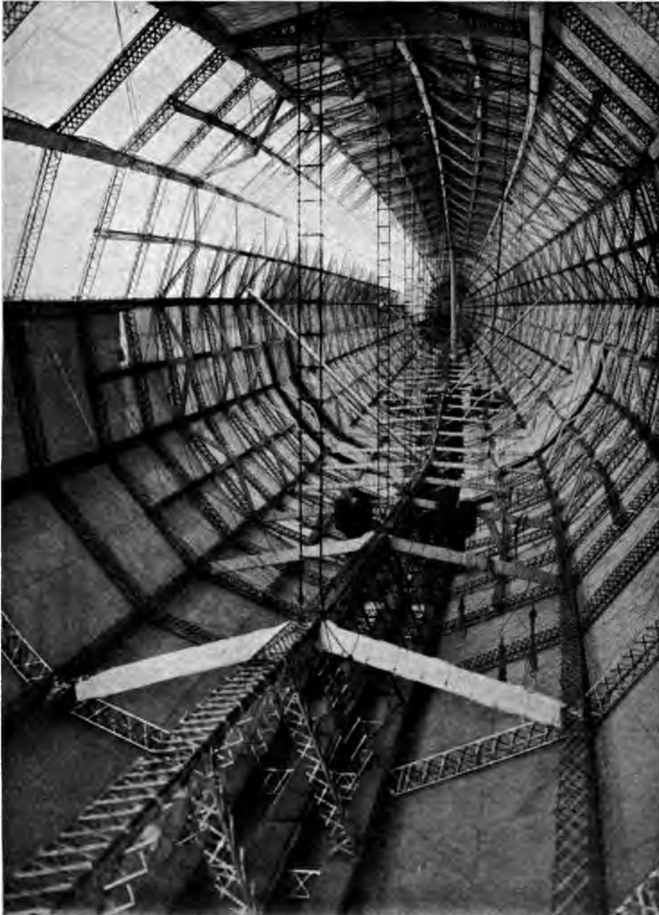
Abb. 22. Marineluftschiff L. 30. Längsblick in das Innere vor dem Einbringen der Gaszellen; Gerippe fertig; unten der sich über die ganze Länge erstreckende Laufgang.
