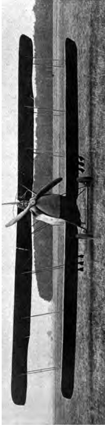
Abb. 78. AEG N I (f. Tab. III, Nr. 40). Dreiflügel mit Balbachin, an den die Oberflügel angeheft werden. 6 je 50 kg-Bomben unter den Tragflächen. Typ 1917.
