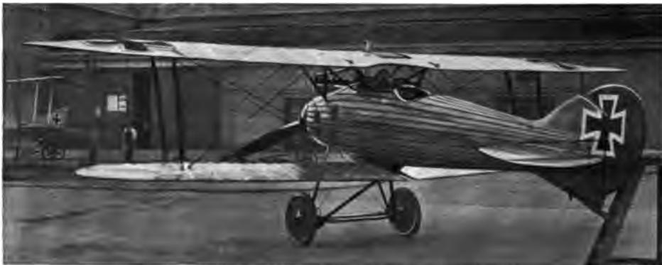
Abb. 66. LFG DVI (s. Tab. II, Nr. 31). Rumpf in Klinterbauart (fester, leichter und reparaturfähiger als der Wickelrumpf); verspannungslose Dämpfungsfächen, unterer Spannriicken (trotz des großen Flügelabstandes Oberflügel fast in Augeshöhe des Führers), gutes Gesichtsfeld, niedriger Rumpfsquerschnitt.
