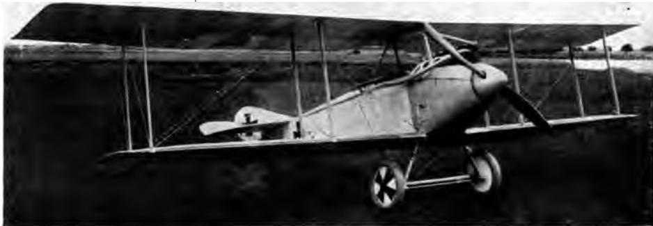
Abb. 51. Aviatik C III/1915 (f. Tab. I, Nr. 5). Für damalige Zeit sehr schnell; günstige Torpedokörperform; Tragflächenführer an Mitte Unterseite oberen Tragdecks. M. G.-Anordnung mittels Gleitschiene zu beiden Seiten des Rumpfes. Beobachter vorn. Geschickte Verspannung des Innenfeldes gab gutes Schußfeld (Kreuzlabel ohne Stirnlabel, Anschluß der Standlabel am oberen Rumpfhorn).
