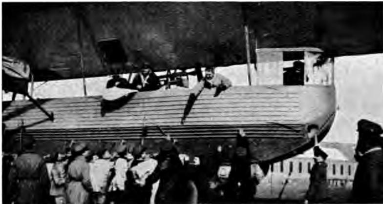
Abb. 15. Offene Führergondel des Z. X aus erster Kriegszeit; darüber der noch unter dem Schiffskörper liegende Laufgang.
