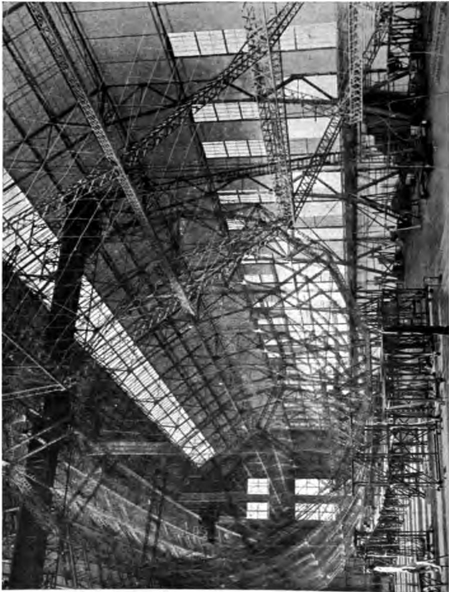
Abb. 7. Verlängerung des Zeppelinluftschiffes L. 59 in Bauphase Staaten. Schiffkörper etwa in der Mitte der Länge zum Einbau eines Verlängerungsgürtels von 30 m Länge auseinandergeklappt und auseinandergezogen.
