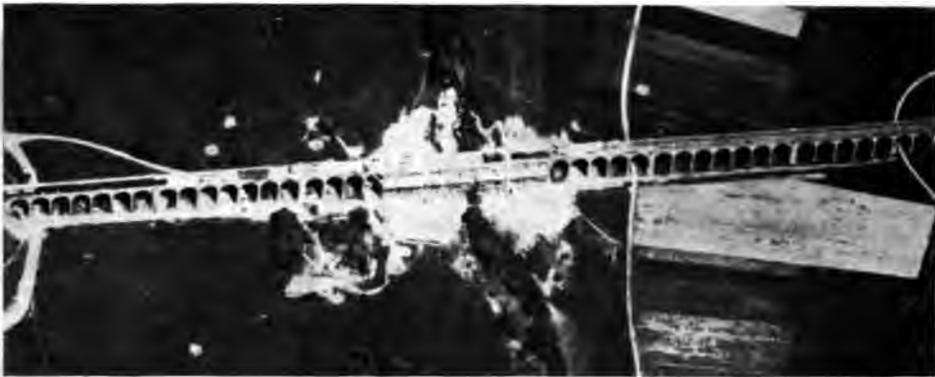
Abb. 262. Wiederherstellungsarbeiten am Viadukt Dammerkirch fast beendet. Durch das Gerüst hindurch die fertigen Bögen, auf dem Viadukt Baubuden und ein Arbeitszug erkennbar.
