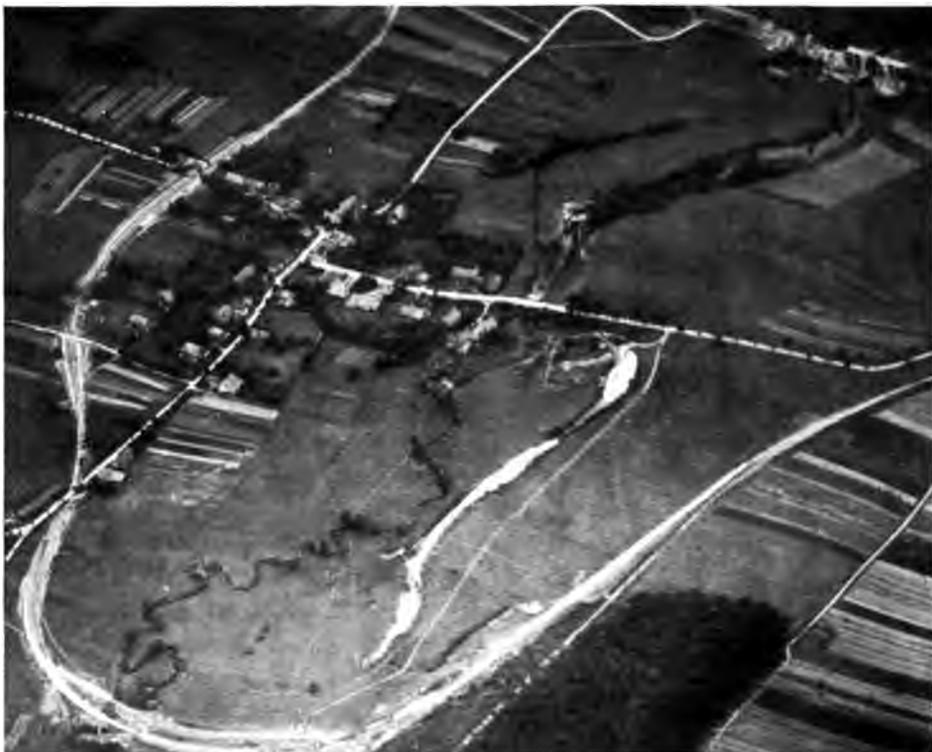
Abb. 264. Umgehungsbahn um den wieder eingeschossenen Viadukt bei Dammertkirch.
