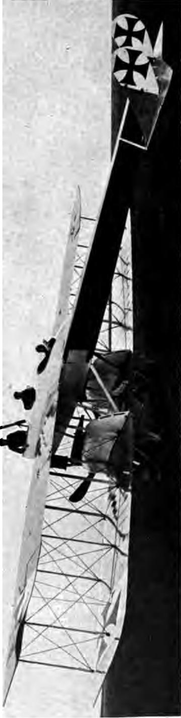
Abb. 56. Gotha G I-Friedel-Urbinus (s. Tab. I, Nr. 24). Erster Versuch der Zueimotorenbauart. Rumpfbauart, bietet drei Griffen, davon Führer hinten, guten Überblick, besonders dem H. G.-Schiffen in der Rumpfspitze. Zwei Motore auf unterer Tragfläche.
