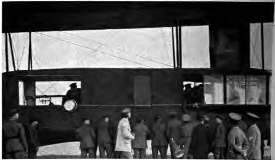
Abb. 181. M. G. in der Führergondel; daneben Scheinwerfer. Rechts Führerstand mit Steigschacht zum Laufgang. Gleichlaufend Knickstreben.
