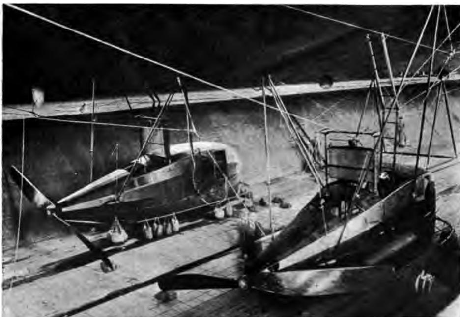
Abb. 28. Zwei hintere, nebeneinanderliegende Einmotorengondeln des S. L. 20.
